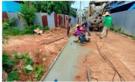
ก่อสร้างรางระบายน้ำ คสล.ถนนถ้ำกระต่ายทอง 1/2 ซอยบ้านผู้ช่วยประสิทธิ์ มะหิมา ชุมชนบ้านบ่อมะเฟือง หมู่ที่ 1 ตำบลถ้ำกระต่ายทอง
